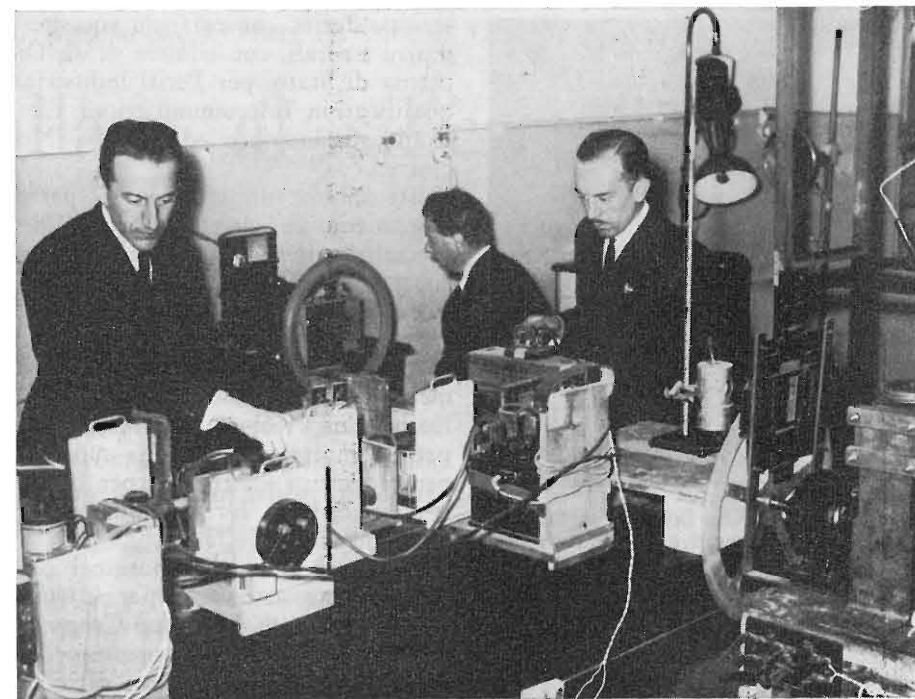
Un laboratorio della prima ora, con le prime esperienze di televisione, ad analisi meccanica.
